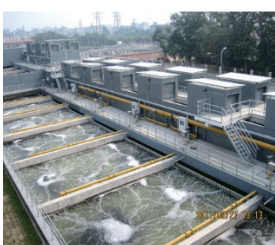
卢沟桥厂（10万立方米/日）
